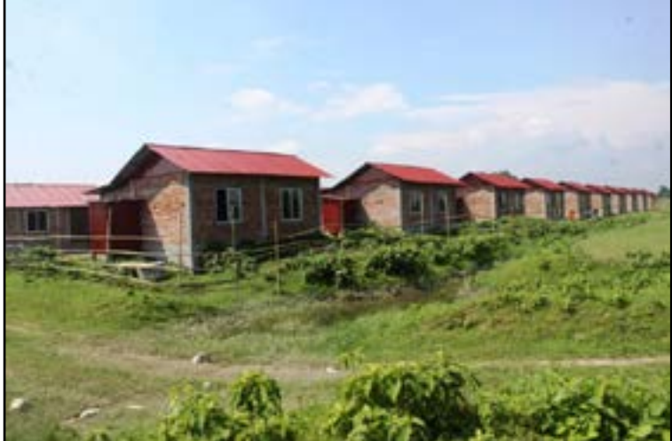
भापाको भापा गाउँपालिका वडा नं. २ कुमरखोदस्थित सन्थाल जातिको लागि निर्माण गरिएका घरहरू।
